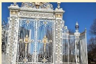
正面玄関の鉄扉
